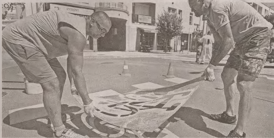
Van, ahol már az útburkolati jeleket festik az elkészült szakaszokon
